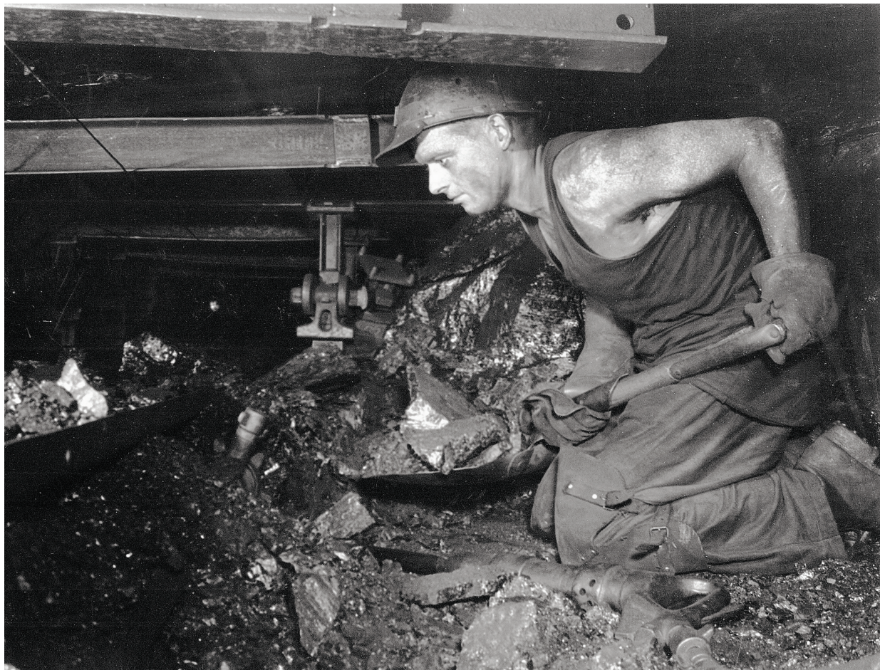
Postsleper W. Mehlkop aan het werk in een schuifpijler in de Oranje-Nassau Mijn II, 1950. Hij schopt de losgemaakte kool op de transportband.
